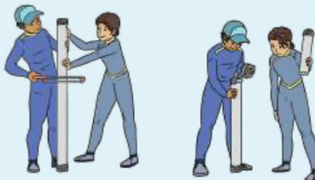
Gambar 6.4 Pipa PVC dipotong untuk membuang air yang ada di bagian
